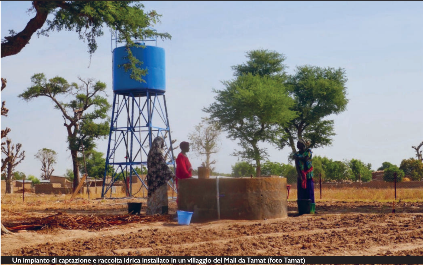
Un impianto di captazione e raccolta idrica installato in un villaggio del Mali da Tamat (foto Tamat)
